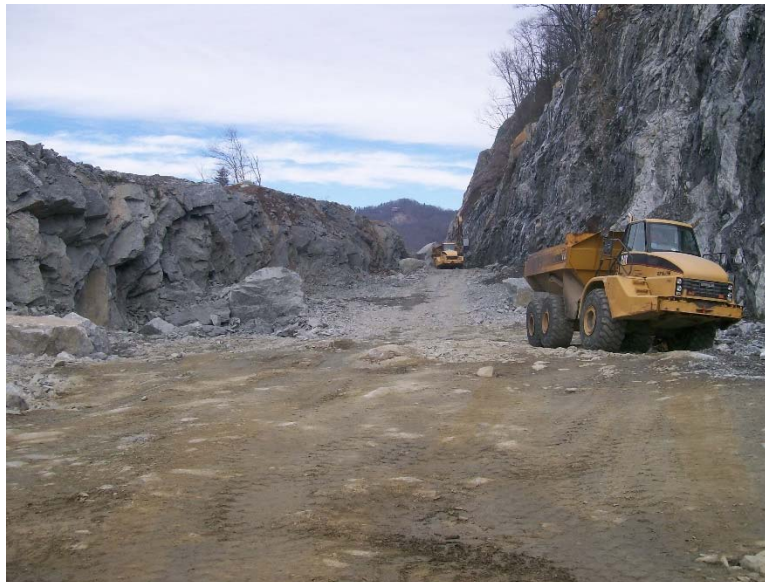
Rock excavation Rte. 321
